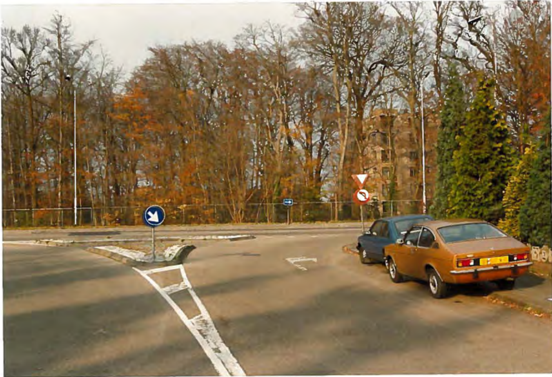
Afbeelding 4. Rechtstreekse aansluiting van een erfteogangsstraat op de Graafseweg (Cavalje) is niet gewenst bij duurzaam-veilig.
