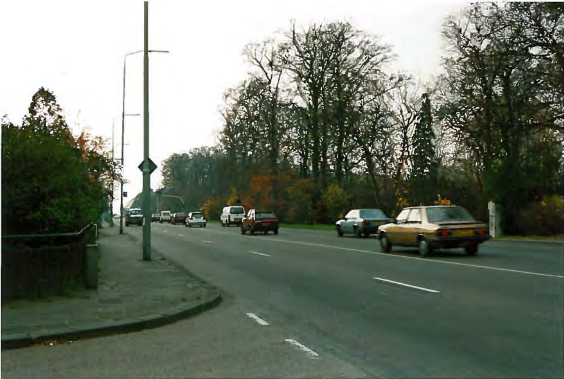
Afbeelding 6. In deze situatie kan een verkeersdeelnemer uit een erftoegangsstraat (Paddepoelseweg) op de Graafseweg terecht komen; verre van duurzaam-veilig!
