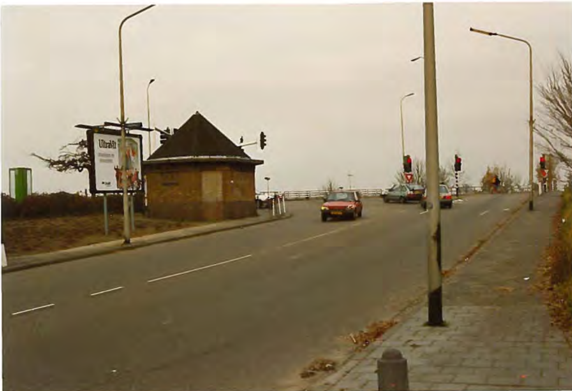
Afbeelding 7. Aansluiting van de Willemsweg op de Graafseweg; een dergelijk aansluiting van een erftoegangsstraat op een stroomweg is ongewenst bij duurzaam-veilig.
