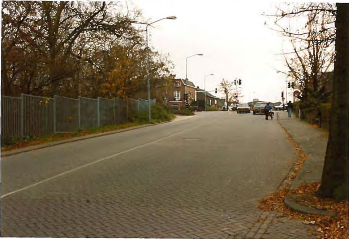
Afbeelding 8. Aansluiting van de Wolfskuilseweg op de Graafseweg; een dergelijke aansluiting van een ontsluitingsweg op een stroomweg is ongewenst bij duurzaam-veilig.
