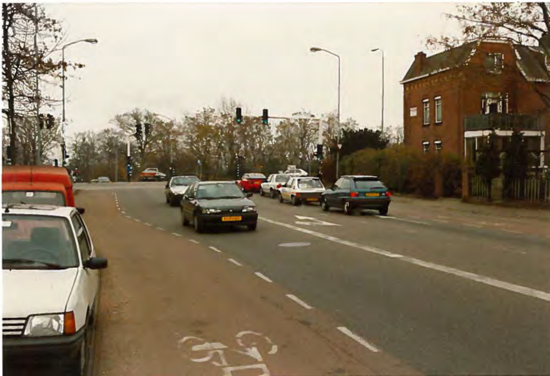
Afbeelding 9. Aansluiting van de Groenestraat op de Graafseweg; uit oogpunt van duurzaam-veilig een ongewenste uitvoering van een dergelijke aansluiting.
