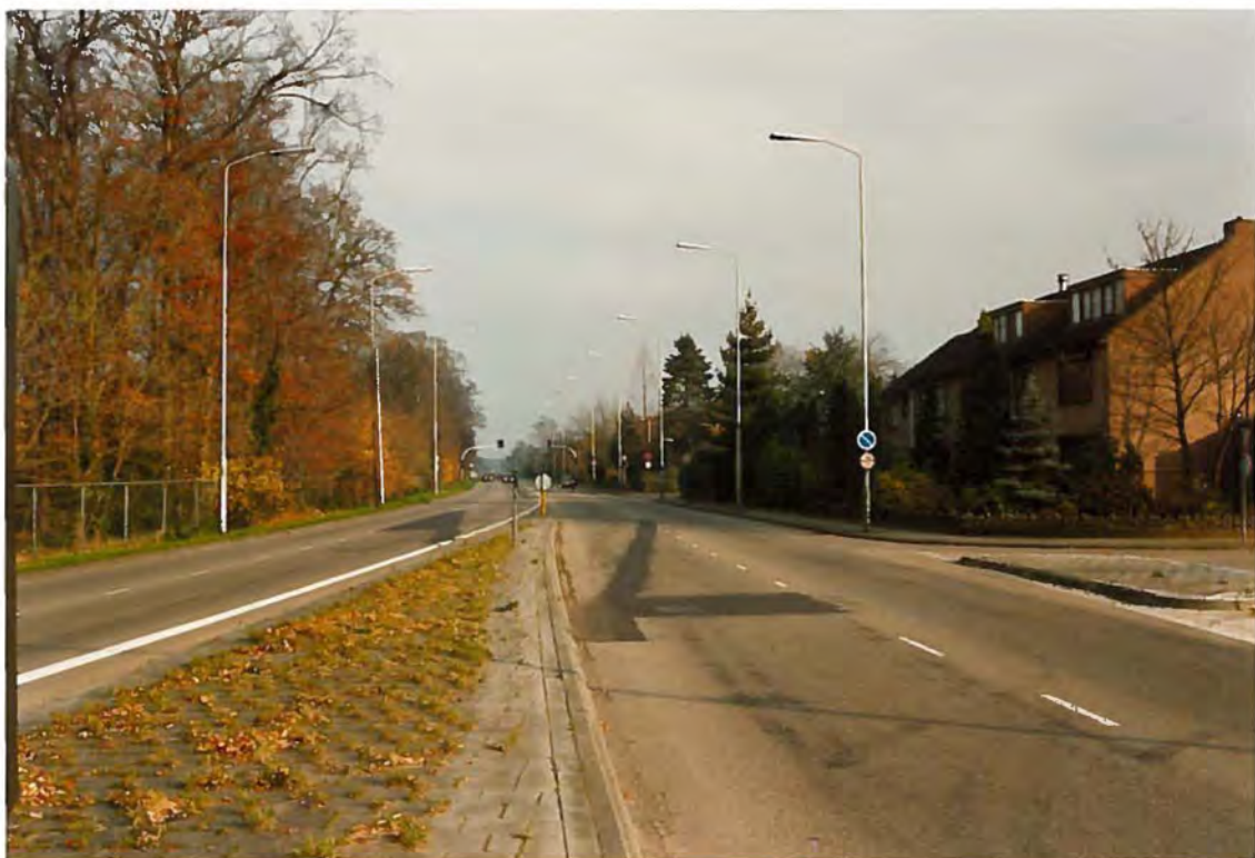
Afbeelding 19. De Graafseweg ter hoogte van Cavalje; voldoet niet geheel aan de ontwerpeisen voor een stroomweg in een duurzaam-veilig situatie (aansluitingen erftoegangsstraten niet toegestaan!).
