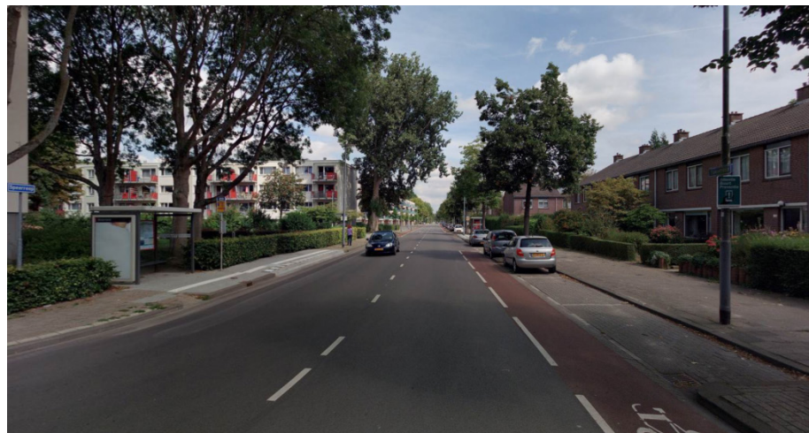
Afbeelding 2.1. Straatbeeld van de Speerreep, met parkeervakken en fietsstroken, en zonder oversteekvoorzieningen over een traject van enkele honderden meters. Bron: Globespotter – Cylcomedia.
