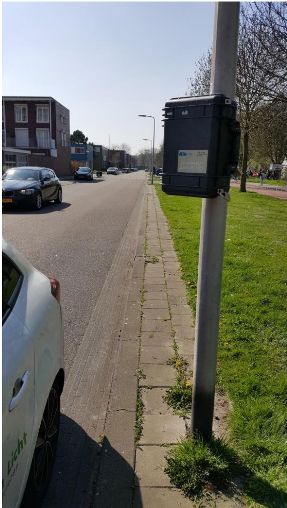
Locatie 3. Nissewaard, plaats Spijkenisse, straat J.A. Heijwegelaan, ter hoogte van D. Schellincxstraat
