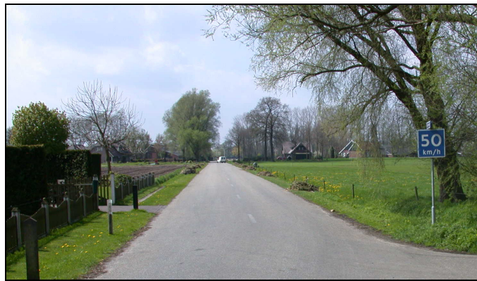
Afbeelding 4.4. De Bollenweg is breder dan 4,5 meter, maar heeft geen kantmarkering. Verder is de asmarkering nog zichtbaar. Op dit gedeelte geldt een maximumsnelheid van 50 km/uur.
