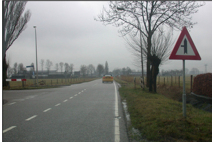
Afbeelding 4.3. Kruising Valkenvoortweg-Blaasbalgweg. Valkenvoortweg heeft asmarkering, doorgetrokken kantmarkering en op de kruising zijn geen snelheidsremmende maatregelen getroffen en is er een voorrangsregeling.
