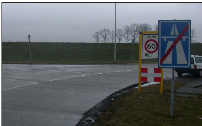
Afbeelding 4.11. Volgens Duurzaam Veilig mag een erftoegangsweg niet direct ontsloten worden door een stroomweg, daarom is de overgang op de Hoogeneindse Rondweg beoordeeld als 'onvoldoende'.
