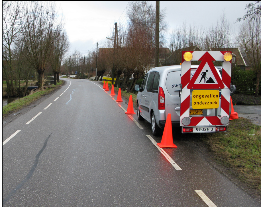
Afbeelding 2.3. Teamauto met afgezet werkvak.
