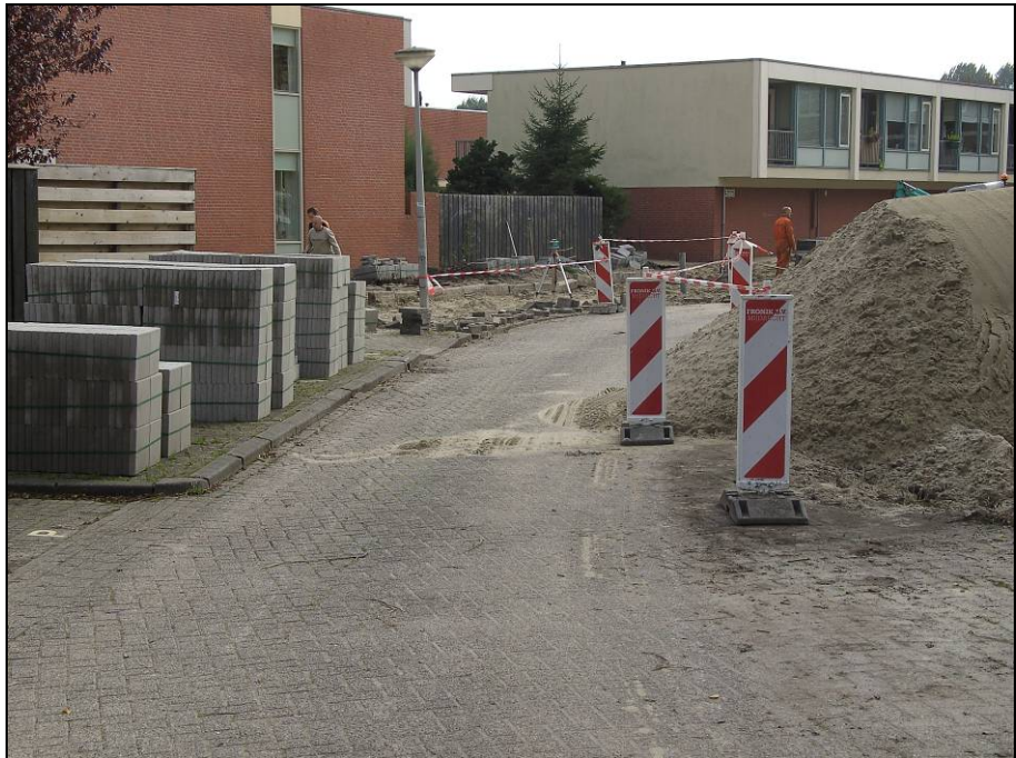
Afbeelding 3.4. Wegversmalling waarbij verkeer elkaar niet kan passeren in een bocht.
