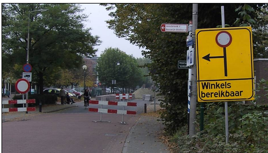
Afbeelding 3.1. Locatie met onduidelijk bord. Het is niet duidelijk via welke route de winkels nu bereikbaar zijn en vanaf waar de weg echt is afgesloten.
