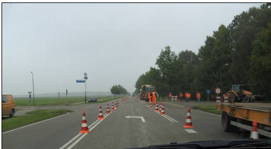
Afbeelding 3.17. Locatie waarbij het uitzicht van overstekende fietsers wordt belemmerd door werkverkeer.
