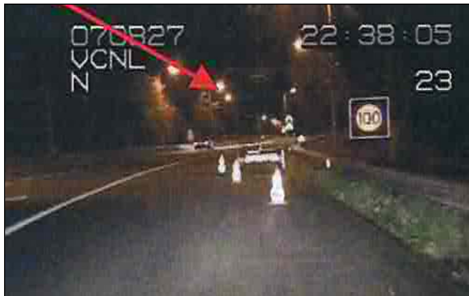
Afbeelding 3.18. Tekstwagen zonder rood-witte rand die slecht zichtbaar is in het donker.
