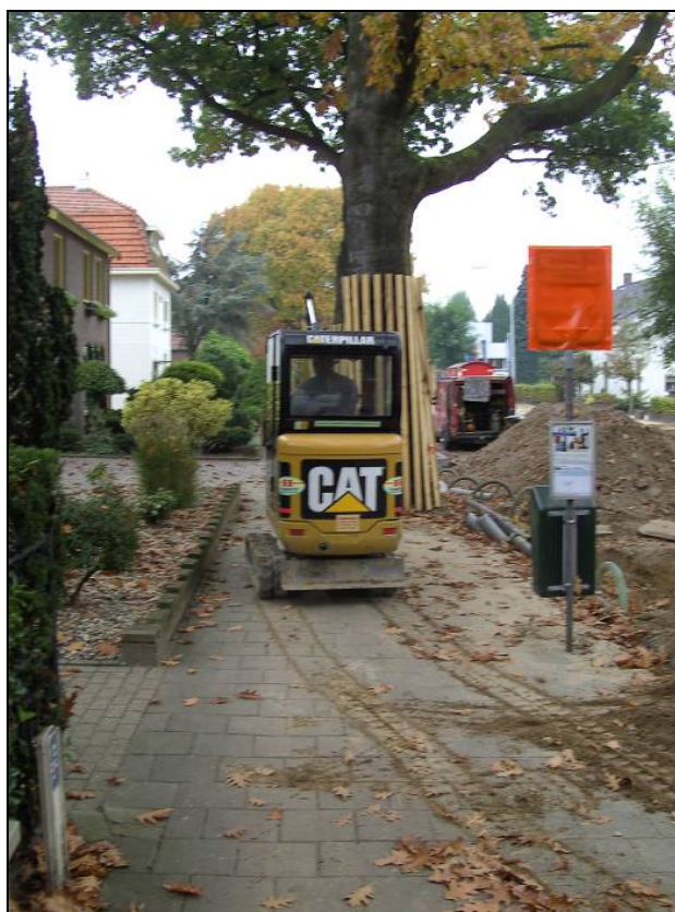
Afbeelding 3.13. Locatie die mogelijk onveilig is voor voetgangers doordat er een werktuig op het trottoir (dat niet is afgesloten) rijdt.
