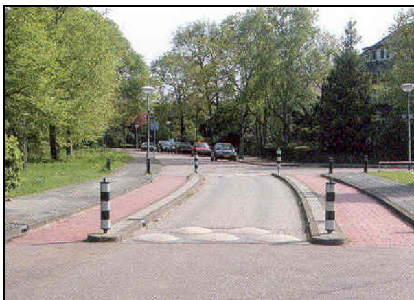
Afbeelding 3.7. Plakpaddenstoelen als sub-optimale snelheidsremmer voor GTW's (CROW, 2003).
