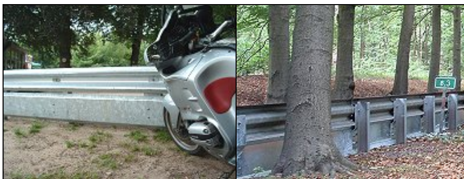
Afbeelding 4.3. Voor- en achteraanzicht van de motorvriendelijke geleiderail (www.mag-nl.org, 2004).
