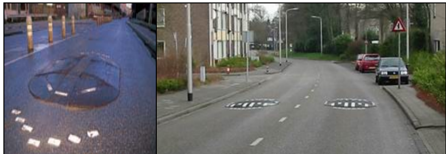
Afbeelding 3.6. Voorbeeld van te smalle verticale snelheidsremmers (www.motorai.nl).
