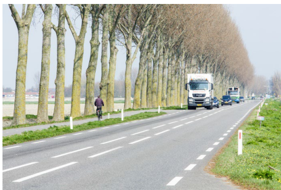
Afbeelding 4. Gebiedsontsluitingsweg buiten de bebouwde kom, zonder fysieke rijrichtingscheiding, met dubbele asmarkering (Foto: Paul Voorham).
